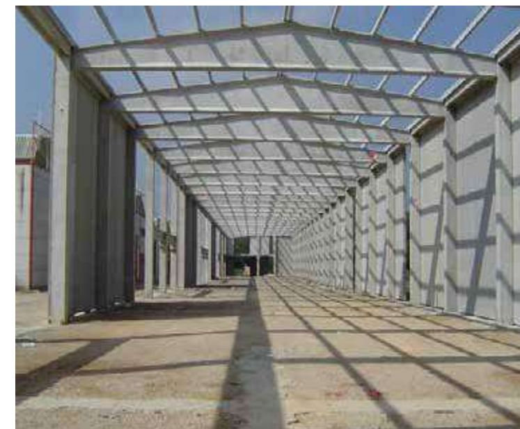
Производственное здание (колонны с несущими консолями)
