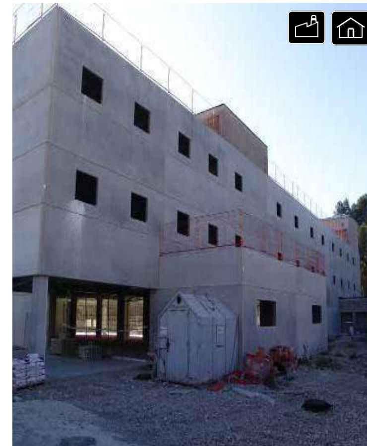
Применение панелей с оконными отверстиями при строительстве производственного здания
