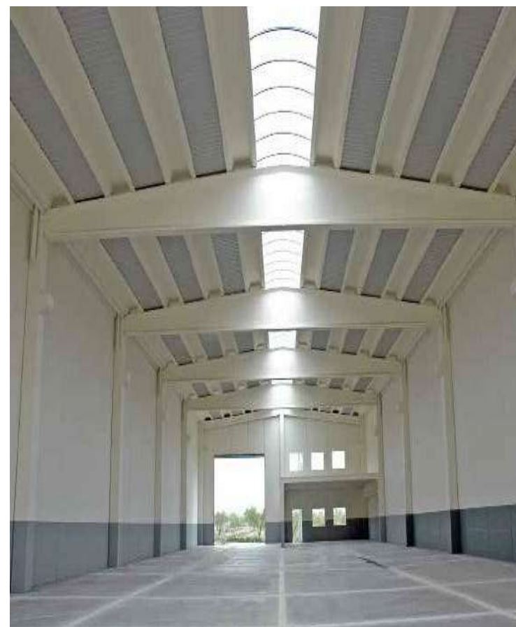
Производственное здание. Вид изнутри.
