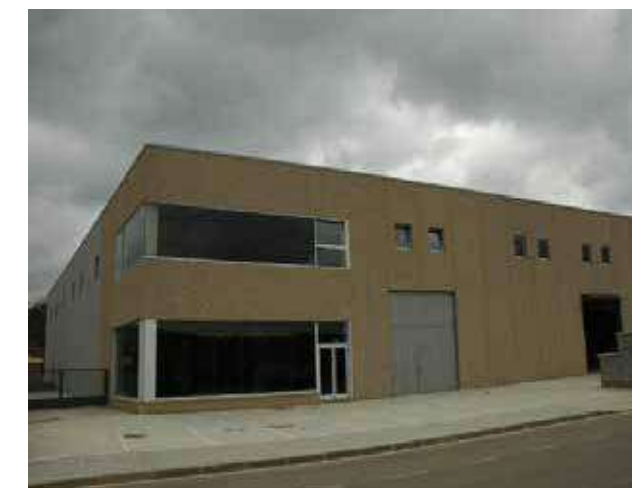
Производственное здание. Панели с фактурной поверхностью.
