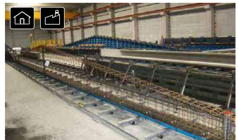
Установленный на универсальной базовой дорожке арматурный каркасдеталь
