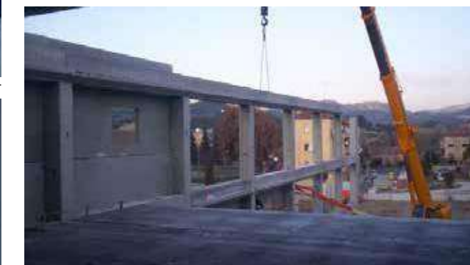
Фрагмент каркаса здания из предварительно-напряженных элементов и конструкций
