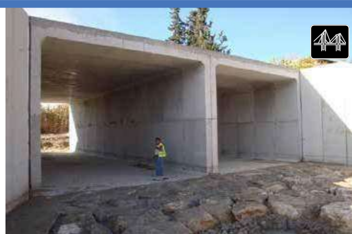
Канал тоннеля автомагистрали
