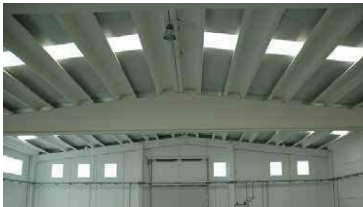
Производственное здание. Вид изнутри.
