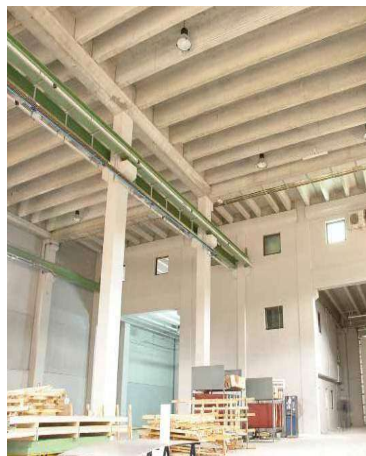
Производственное здание. Вид изнутри.
