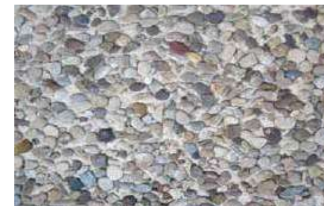
Стеновая панель с лицевым слоем под натуральный камень (галька)
